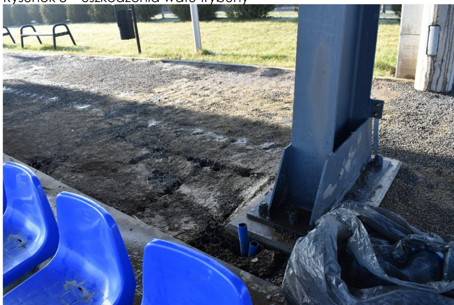
Rysunek 8 – uszkodzenia wału trybuny
