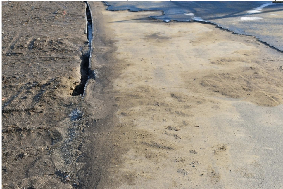
Rysunek 7 – zniszczenia podbudowy nawierzchni bieżni (fotografia własna)
