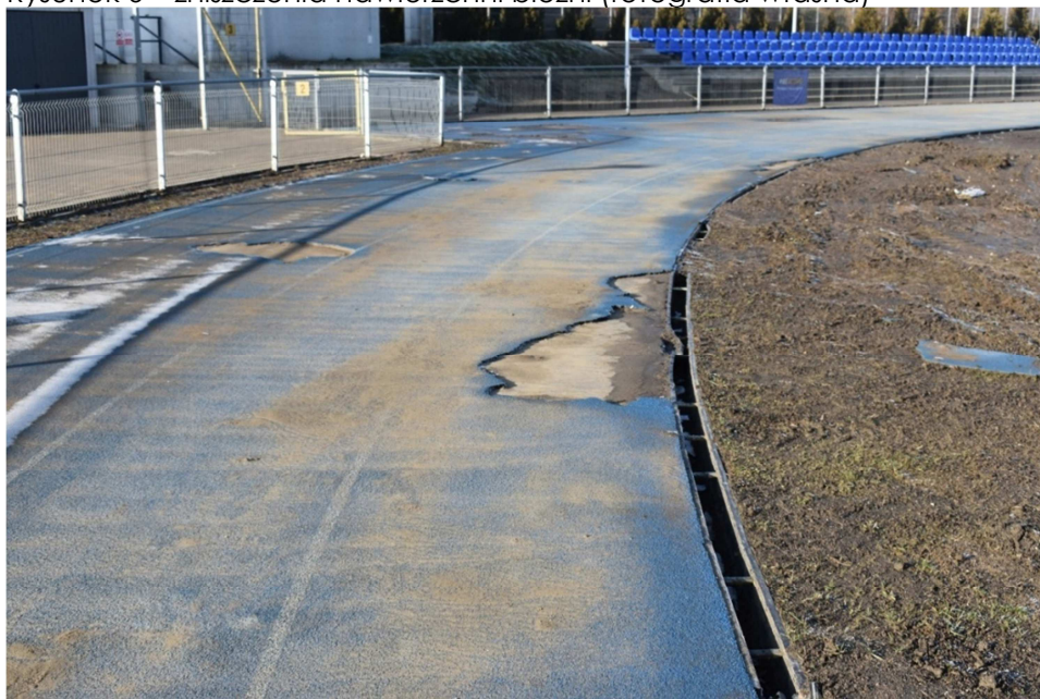
Rysunek 6 – zniszczenia nawierzchni bieżni (fotografia własna)
